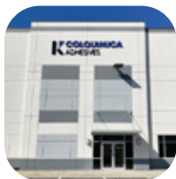
COLQUÍMICA ADHESIVES PLEWISKA, POLAND
